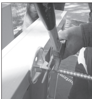
Asenna muotin toinen seinä ja kiristä muottisiteet.
