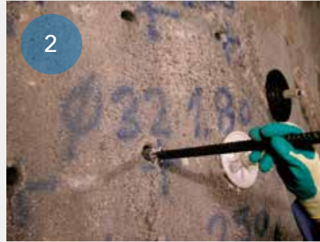
Työnnä hitaasti kovettuvat polyesteripatruunat reikään.
