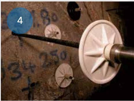
Sekoita polyesteripatruunat pulttia kiertämällä.
