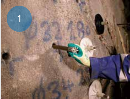
Työnnä nopeasti kovettuvat polyesteripatruunat reikään.
