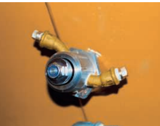
Vaakasuuntainen huuhtelusuutin vaihteiston yläosan ja sekoitusvarsien puhdistamiseen.
