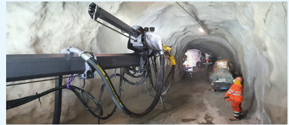
Ruiskubetoni- Bermasse-tunneli
